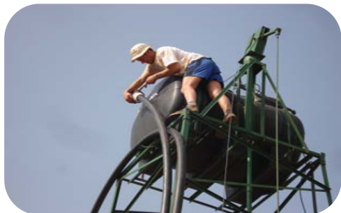
Frédéric raccorde la citerne située au dessus du réservoir
