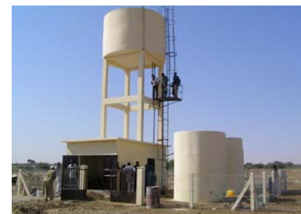
Le génie civil de la station de Fanaye Walo terminé
