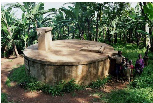
Réservoir alimentant l'hôpital de Monvu
