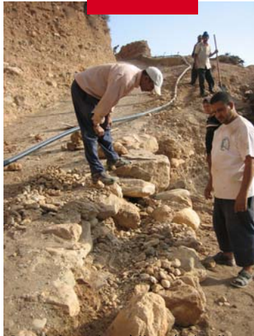
Pose de la conduite à l'entrée du village
