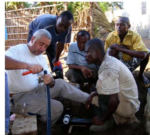
Reprise des branchements pour l'alimentation des bornes-fontaines
