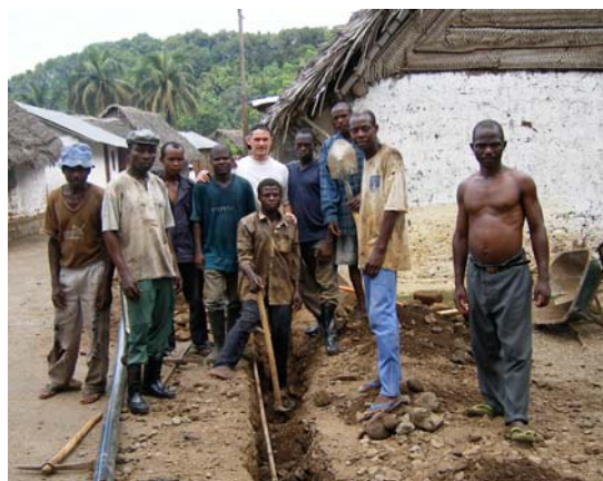
Pose de conduites en polyéthylène
