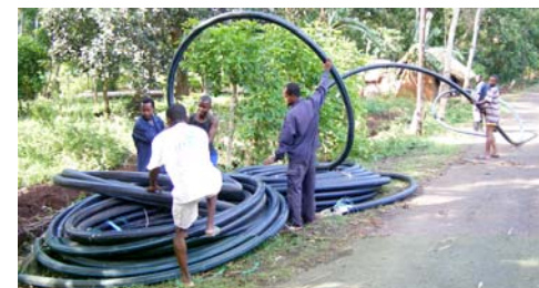
Déroulement de la couronne DN 90, longueur 100 m
