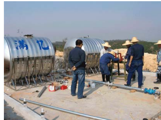
Installation d'un refoulement - distribution aux réservoirs
