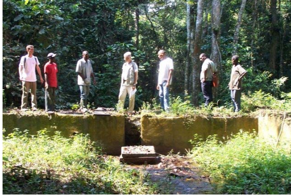
Barrage de Quitoque réutilisé
