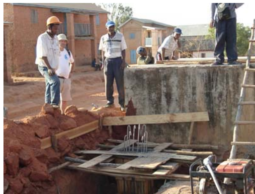
Coulage du béton des piliers du réservoir
