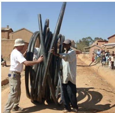
Déroulement des câbles en polyéthylène haute densité
